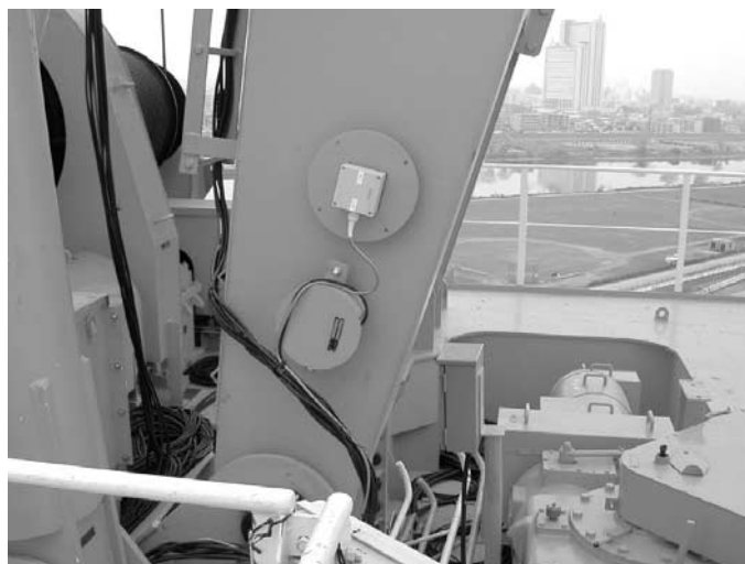
ジブの根元に、傾斜計をマグネットで取付け
