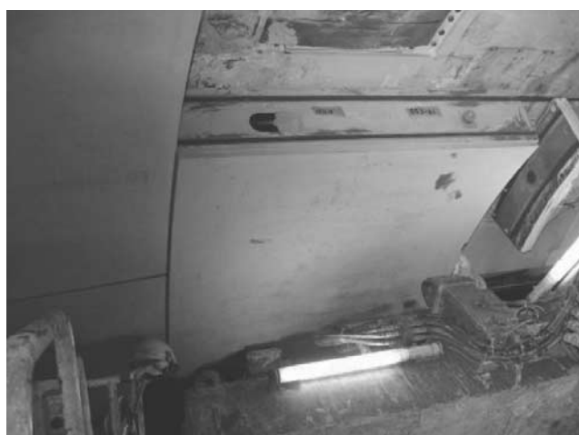
写真-1 セグメント組立状況
