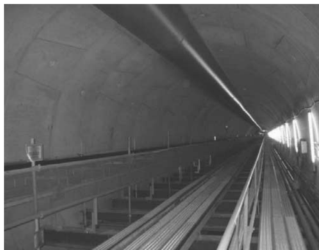
写真-2 トンネル全景
