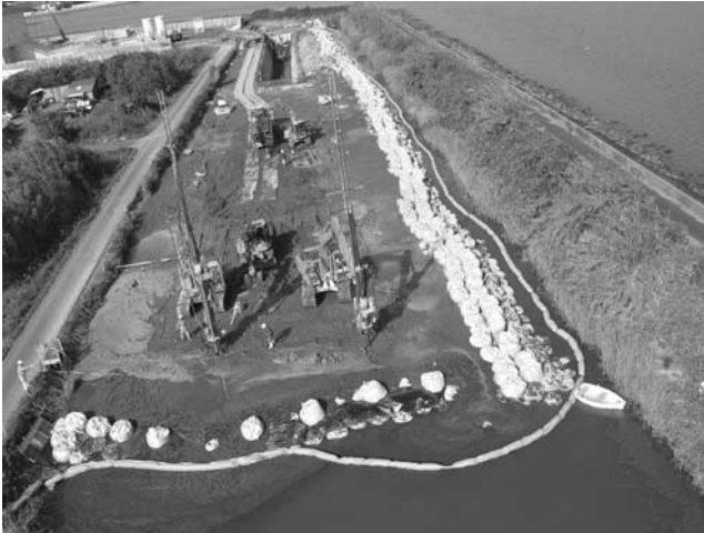
写真—4 超軟弱地盤上での施工状況
