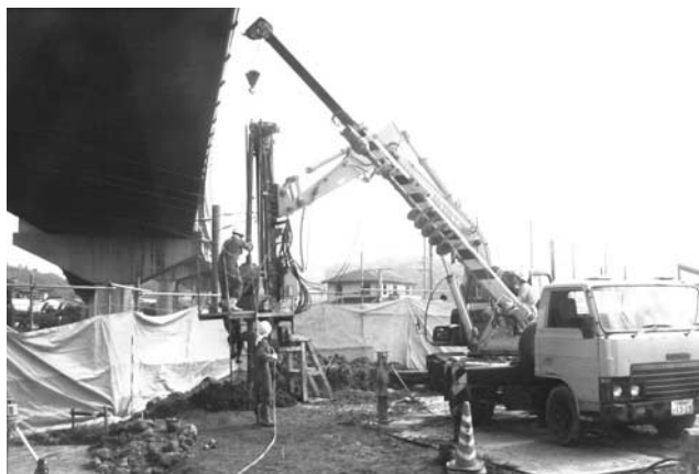
写真-3 上空制限下での施工状況
