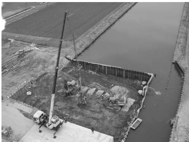
写真-2 構造物基礎施工状況
