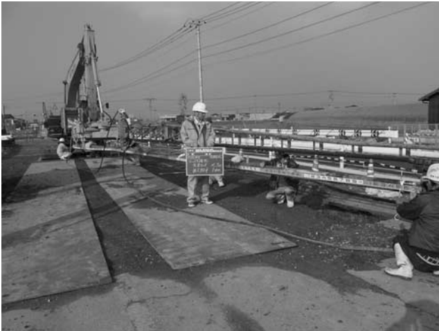
写真-1 リーダー部の倒伏状況
