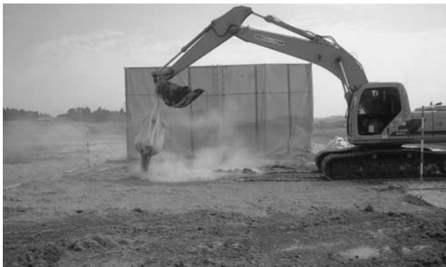
写真—5 散布時の改良材の飛散
