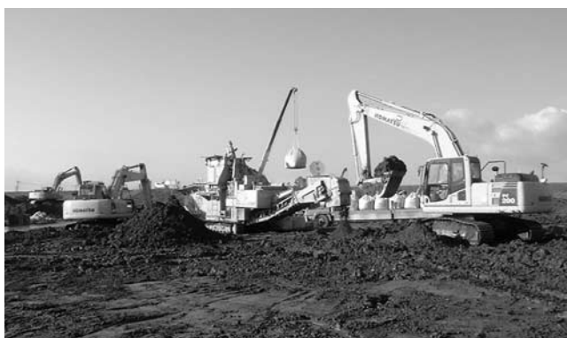
写真—6 護岸掘削改良工事状況（事例1）
