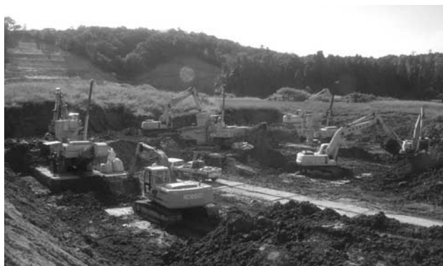
写真—7 築堤改良工事状況（事例2）
