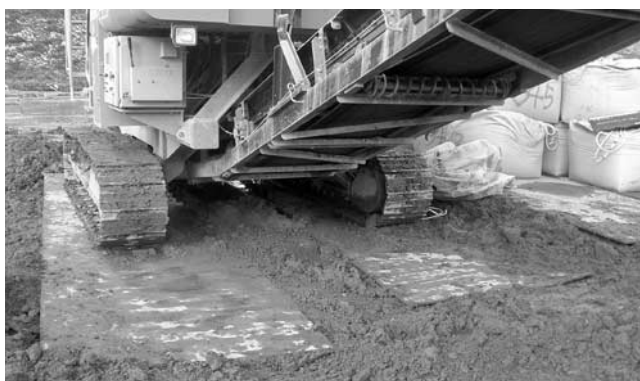
写真一 2 敷鉄板の設置例
