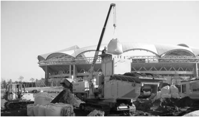
写真—8 地盤改良工事状況（事例3）
