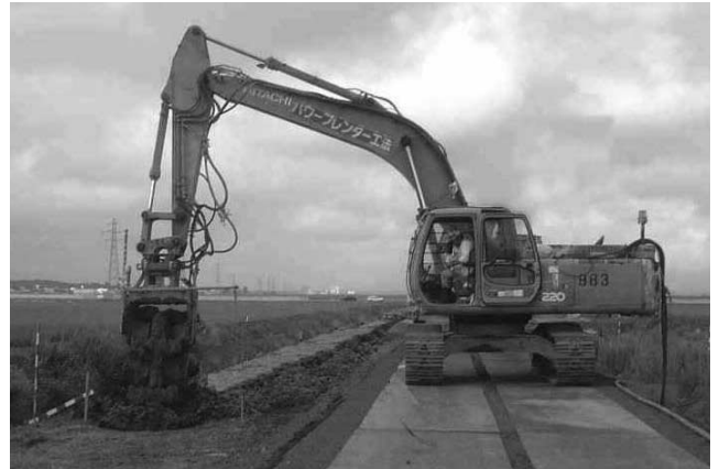
写真一5 地中連続壁の造成状況
