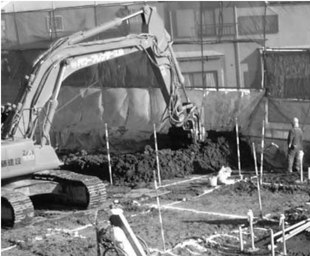
写真一4 施工状況
