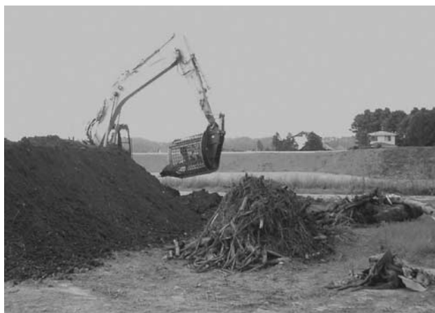
写真一 2 分別施工状況
