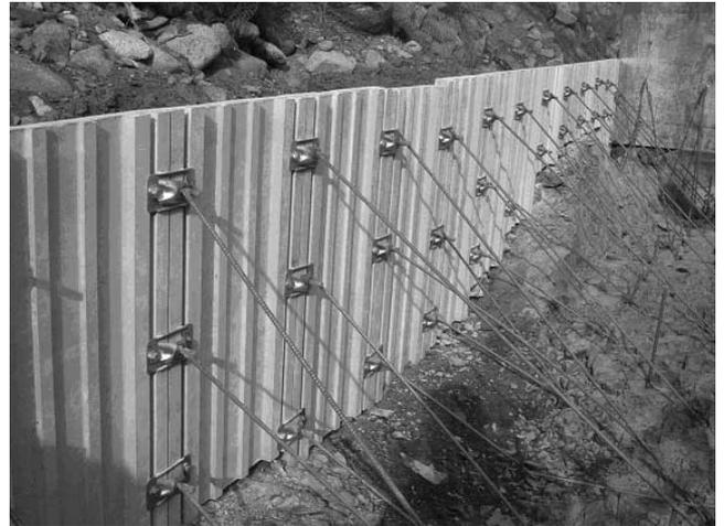
写真—7 縦使いの施工例
