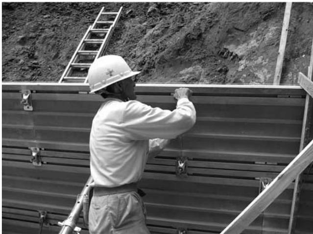
写真—6 接続金物の取付状況
