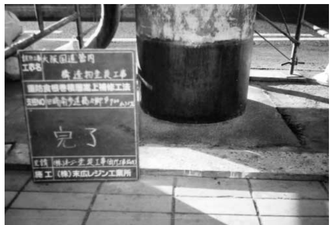
写真一七 *街・やすらぎ【JNK 工法】*完了
