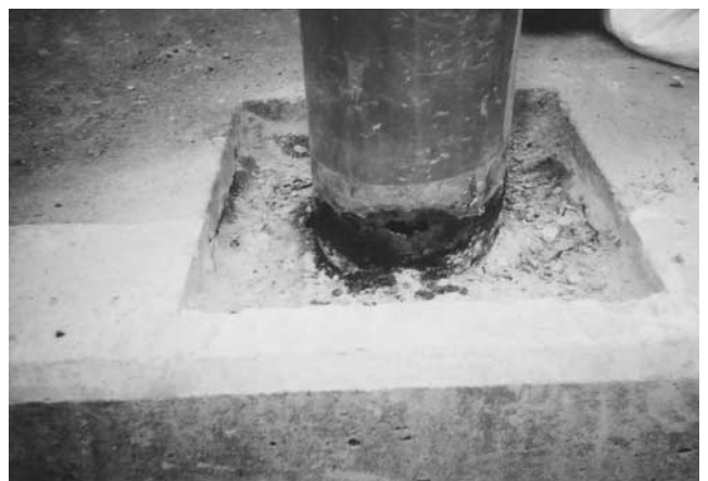
写真一3 道路照明灯；構造耐力限界期
