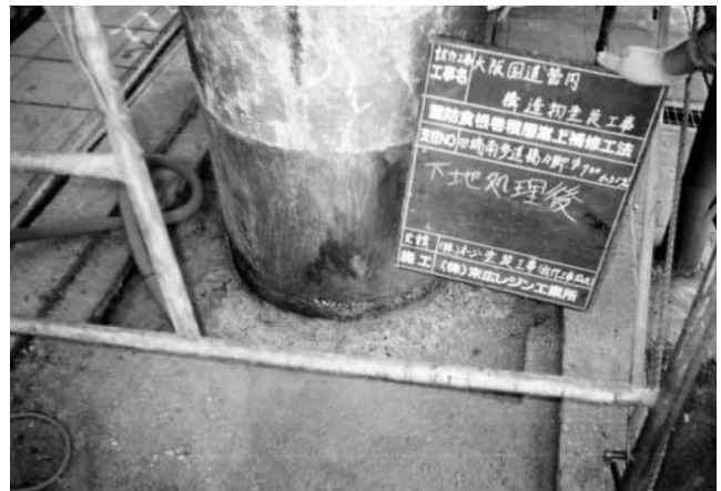
写真一五 はつり粗面化・下地処理後
