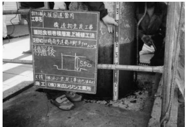
写真一六 重防食根巻積層後
