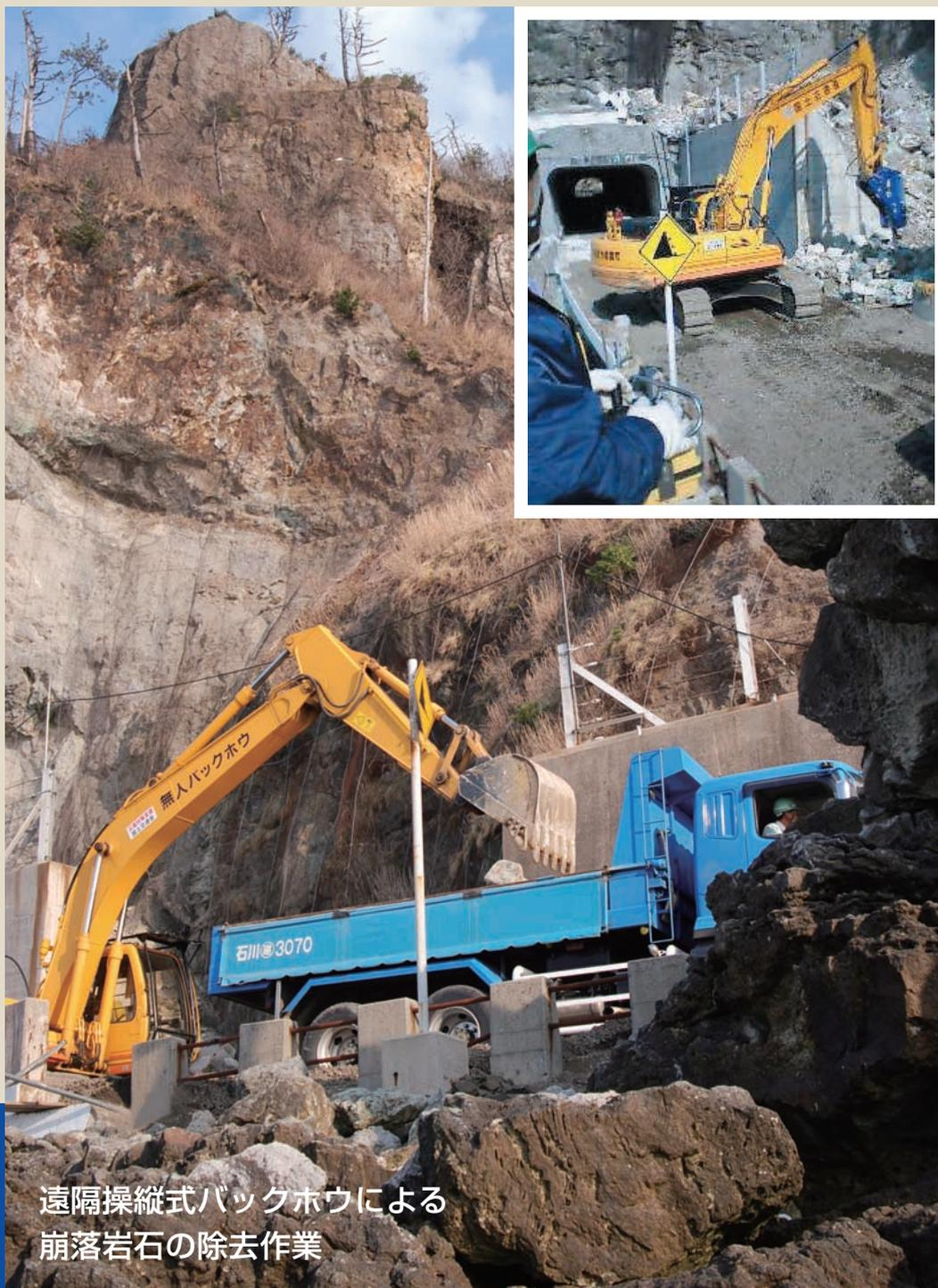
遠隔操縦式バックホウによる
