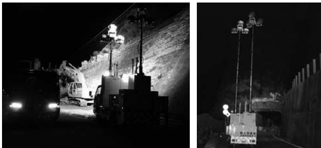
写真—9 照明車による夜間作業支援
