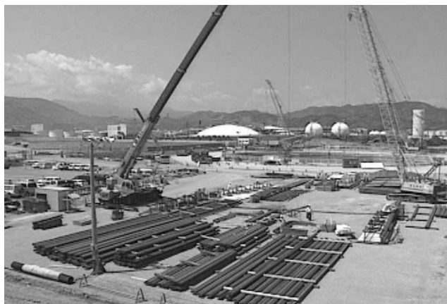
写真—1 LNG地下式貯槽建設作業所の全景
