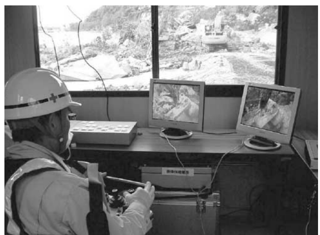
写真—6 遠隔操作式バックホウ操作状況
