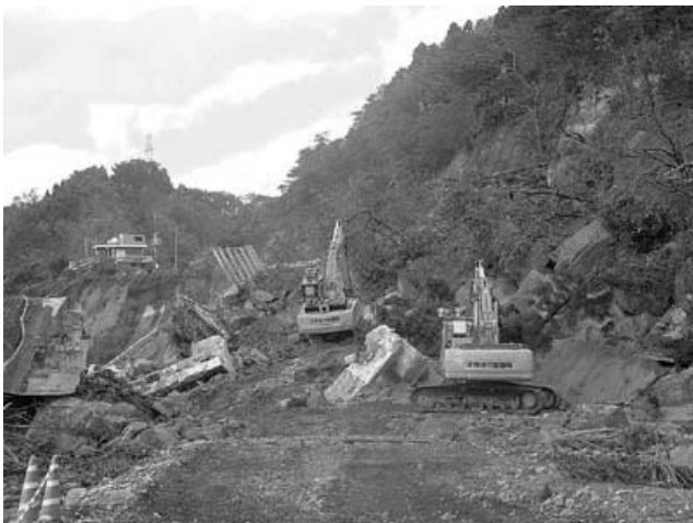
写真—5 遠隔操作式バックホウによる被災者救出状況（長岡市妙見地先）
