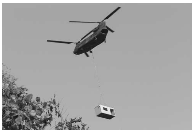
写真—4 ヘリコプターによる重機の空輸
