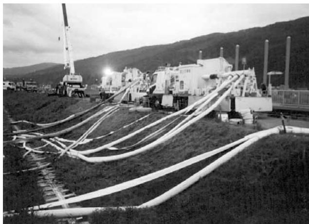
写真-1 排水ポンプ車による排水活動 (H16.7.18 福井豪雨災害 福井市 狐川)
