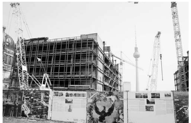
写真—66 共和国宮殿解体現場
