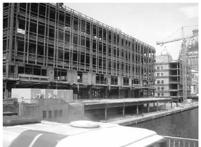
写真—67 共和国宮殿解体現場とシュプレー川
