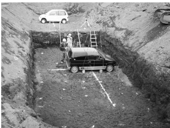
写真-1 実験ヤードの造成(6×20m×深さ4m)(車両埋設位置決め)
