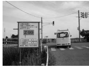
写真-4 工事看板
