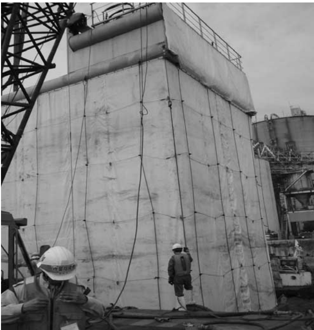
写真-3 汚濁防止膜の組立状況
