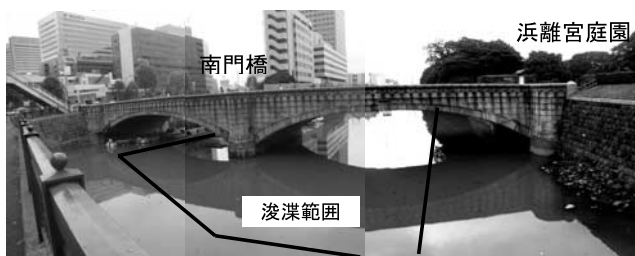
写真—1 浚渫範囲全景
