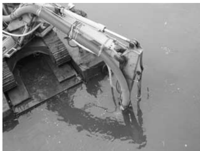
写真一四 吸泥状況
