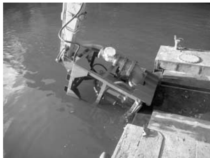
写真—2 汚濁抑制吸引口
