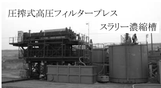
写真—9 中間処理施設全景
