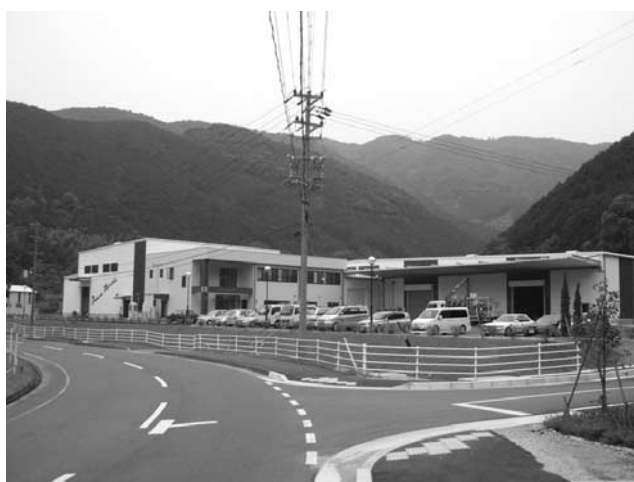
写真-4 工業団地に整備された飲料水製造工場
