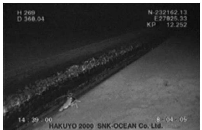
写真一九 取水管設置状況
