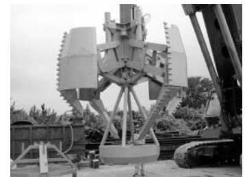
(a) 中間拡径部掘削時
