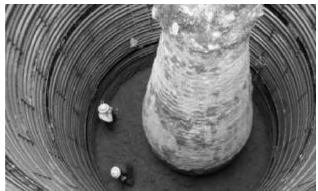
写真一2 杭体の掘出し状況(深礎工法)
