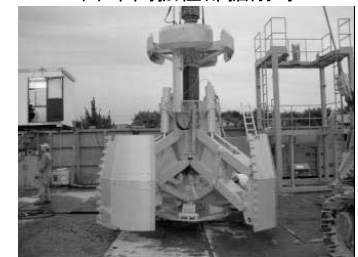
(b) 拡底部掘削時
