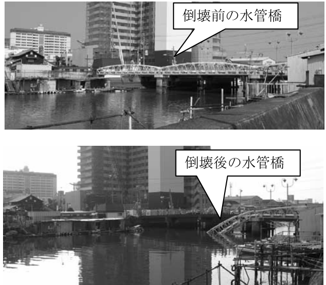
写真-1 水管橋の状況（上段：倒壊前、下段：倒壊後）
