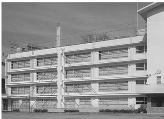
写真—2 パラレル補強後の景観
