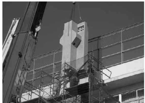
写真一五 PCa 柱部材の建て込み
