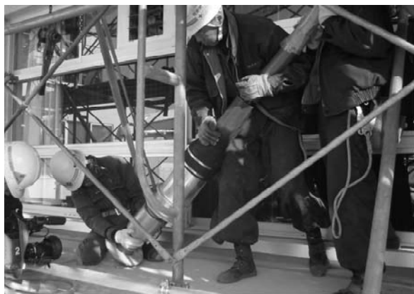
写真一六 斜め PC 鋼材の固定端の取付け
