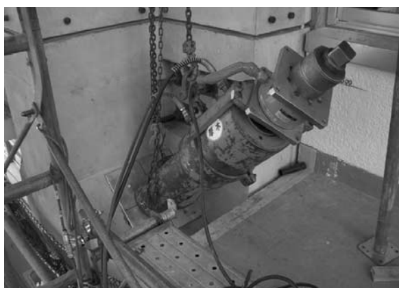
写真一七 斜め PC 鋼材の緊張
