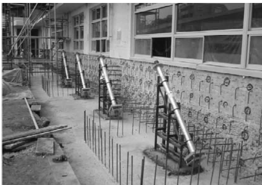
写真一四 斜め PC 鋼材固定用治具設置
