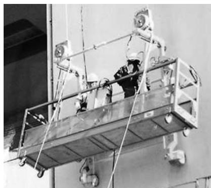
写真—1 磁石車輪ゴンドラ
