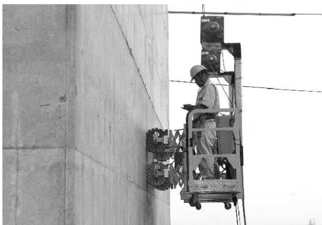
写真一2 真空吸着車輪ゴンドラ
