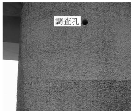
写真—10 コンクリートはつり面の状況（WJ工法後）
