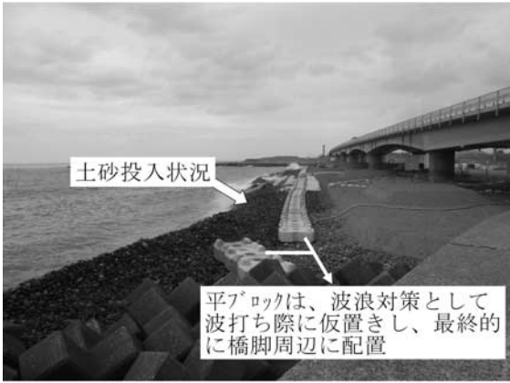
写真一六 土砂投入状況
