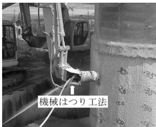
写真—9 機械はつりによる施工状況
