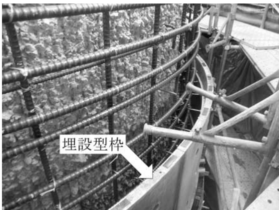
写真一七 埋設型枠取付け状況
