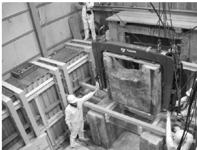
写真—4 II型治具南壁石用使用 南壁石 (835 kgf, 118 × 137 × 54 cm)
