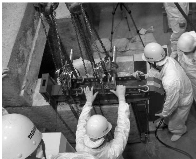
写真—6 Γ型治具使用 東側壁石 3 (685 kgf, 116 × 89 × 42 cm)
