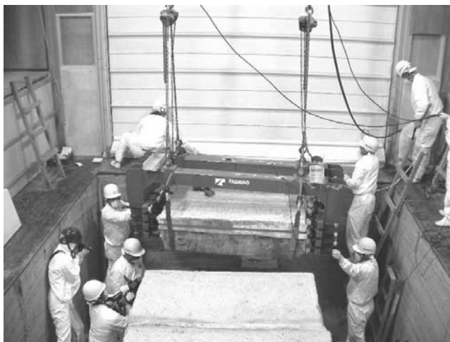
写真-1 最北側の天井石4の解体 (1128 kgf, 162 × 103 × 46 cm)
