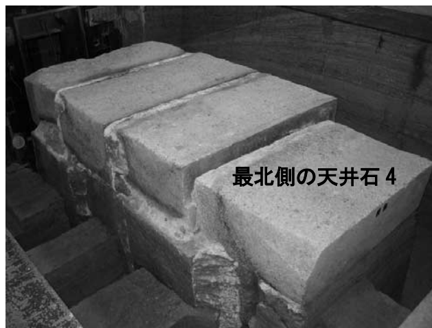
写真-2 最北側の天井石4の解体前日
