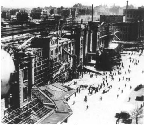
写真—2 戦争による被災状況
