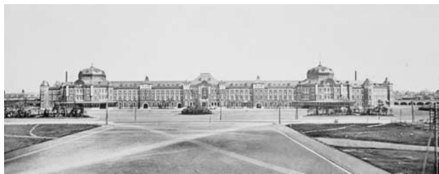
写真—1 外観（創建時）
