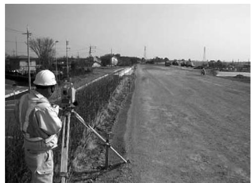
写真一 3 TS による出来形計測状況
