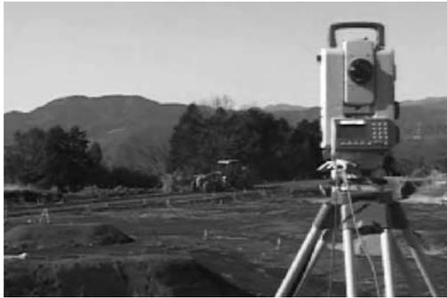
写真一 2 情報化施工路盤整形時の状況
