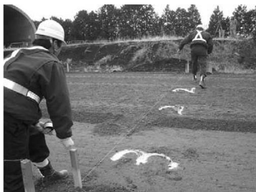
写真-1 現行施工路盤整形時の確認作業
