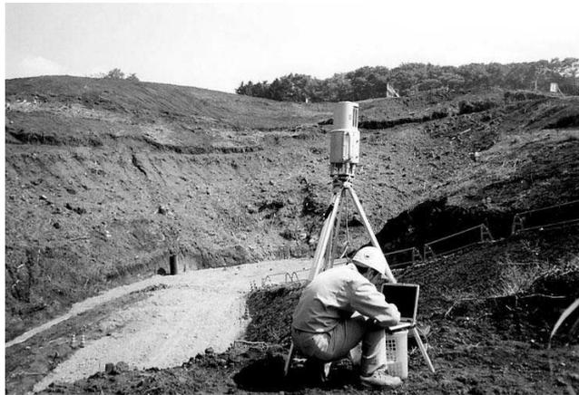
写真-2 3次元レーザースキャナーでの計測状況
