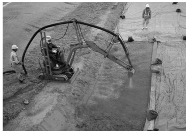
写真一4 吹き付け施工状況
