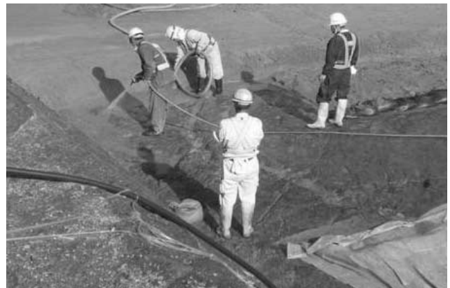
写真一2 岩盤清掃状況
