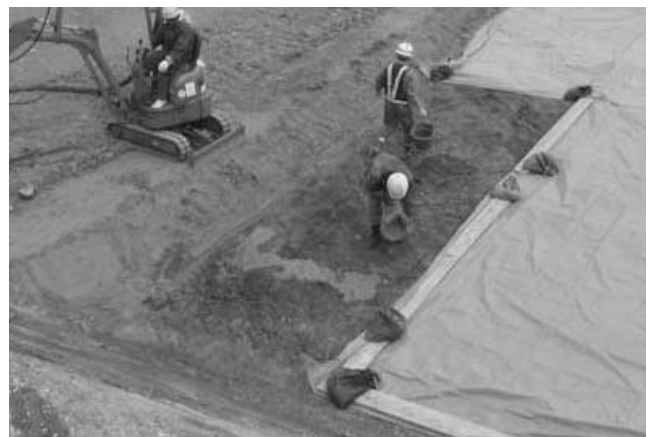
写真一3 クレイサラリー塗布状況
