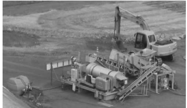
写真一1 システム全景 (吹き付け用バックホウを除く)
