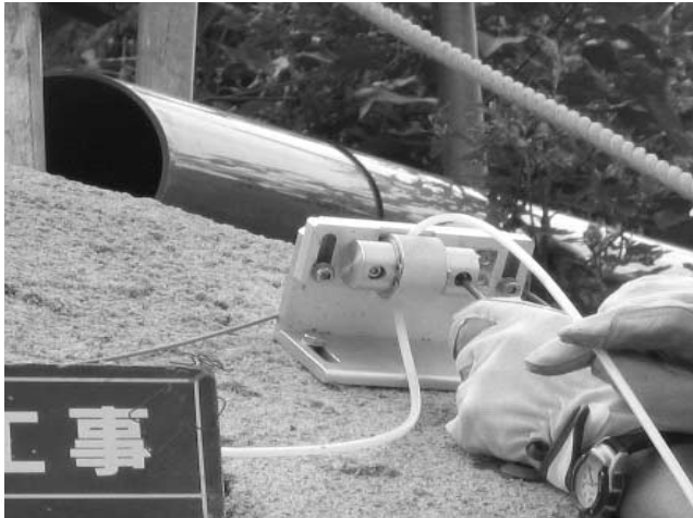
写真-4 固定端部の設置状況
