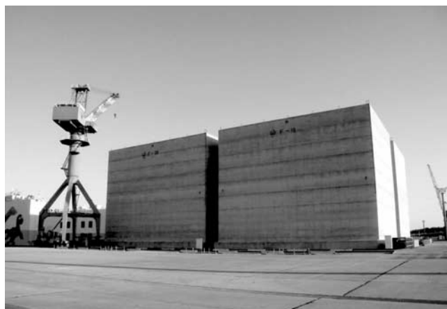
写真—1 本システム適用現場の竣工写真
