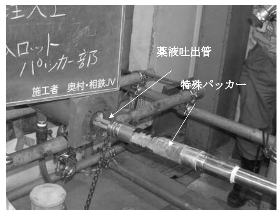
写真—4 一次止水 (薬液注入)
