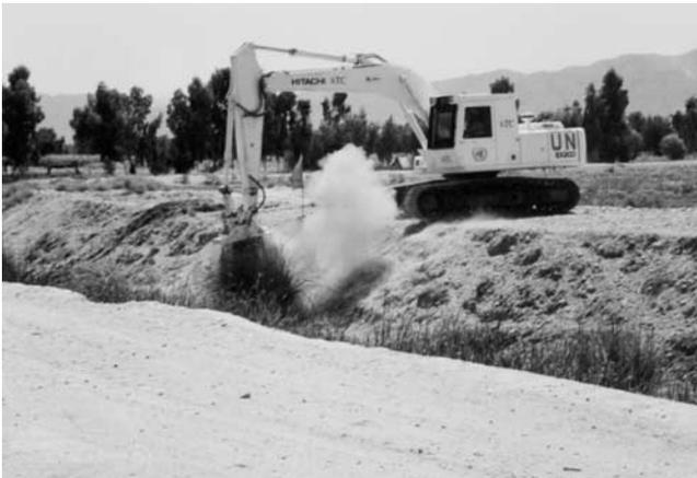
写真一 2 河川の法面部の地雷の撤去
