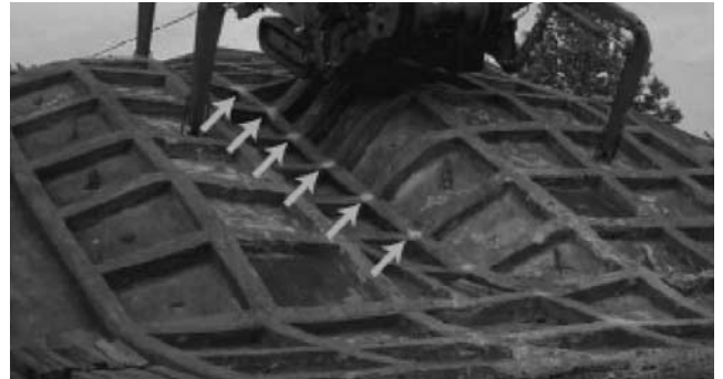
写真一七 模擬法面での移動と削孔
