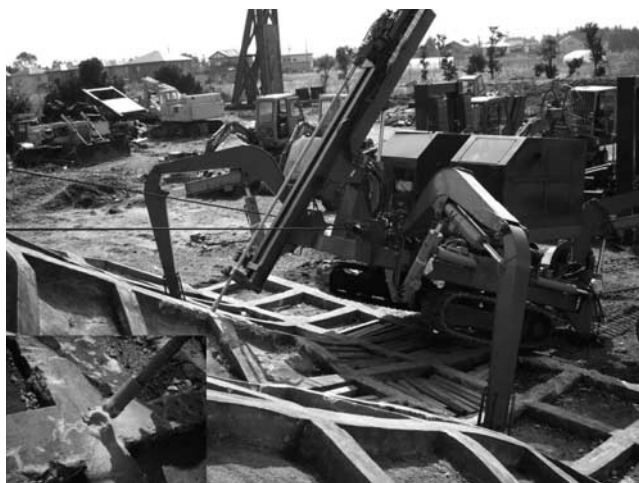
写真—5 模擬法面で削孔を行う TITAN XI
