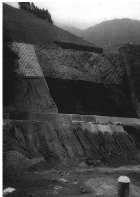
写真—1 大規模な法面の例
