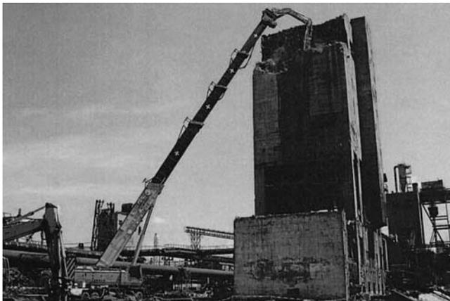
写真—5 コークス装入炭槽解体状況
