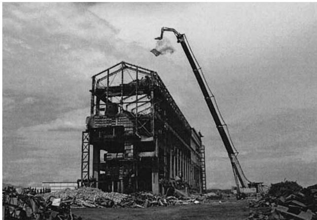
写真—4 鉄骨造建屋解体状況
