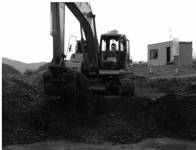
写真—10 施工能力確認試験状況
