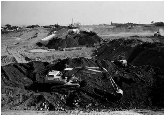
写真—2 除石状況
