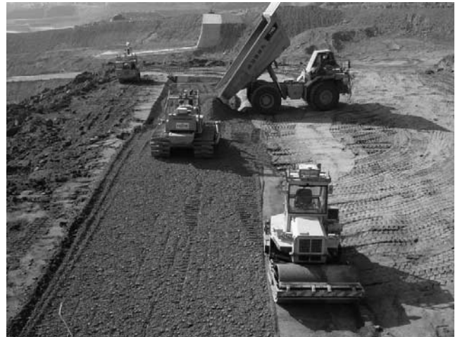
写真—3 RCC(Roller Compacted Concrete)の敷き均し及び転圧状況
