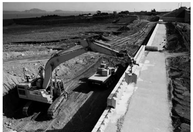
写真—4 プレキャストコンクリートブロック据付け
