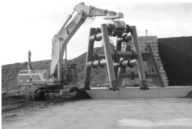
写真—5 微調整機能のある把持装置を装備した無人バックホウによる鋼製スリットの据付け
