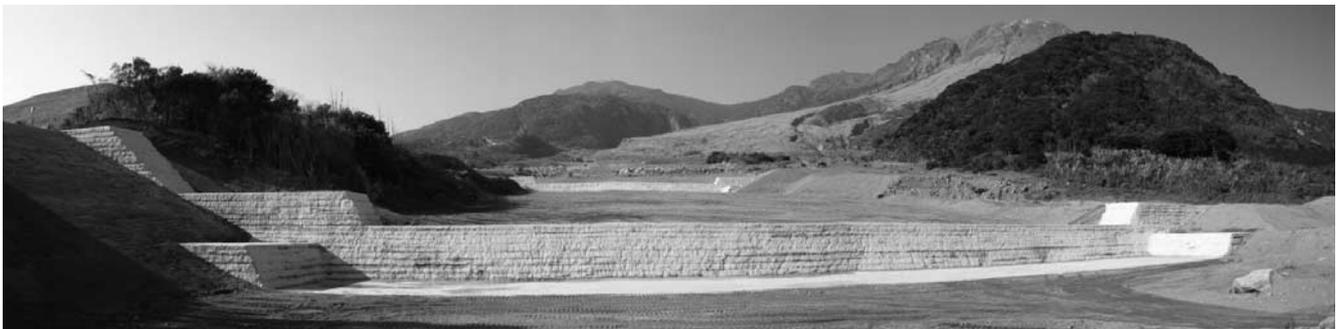
写真—1 赤松谷川1号床固工
