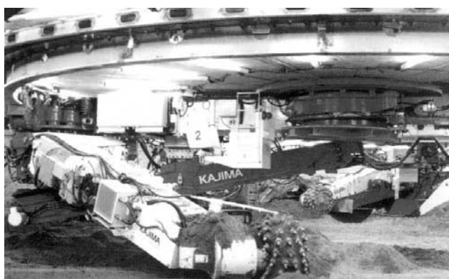
写真一4 自動化施工事例 2)
