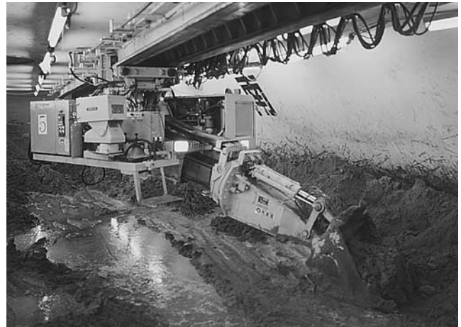
写真一 天井走行式掘削機
