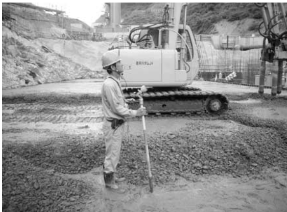
写真一 2 コンクリート打設位置指示状況
