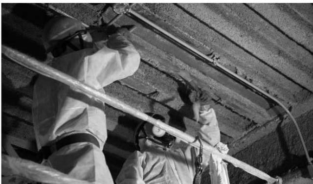
図-1 アスベスト除去工事
