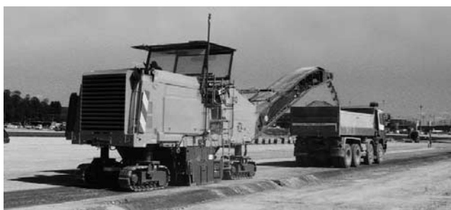
写真—4 TS-3D-MC による路面切削機制御
