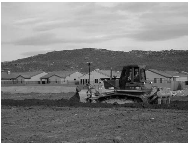
写真—5 GPS-3D-MC ブルドーザによる宅地造成工事(米国ユタ州)
