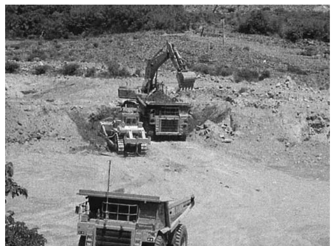
写真一 12 油圧ショベル、重ダンプ、ブルドーザによる無人化施工
