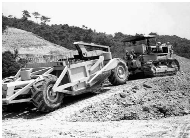
写真一7 D120トラクタに牽引されるRS09 キャリオールスクレーパ1964年（昭和39）
