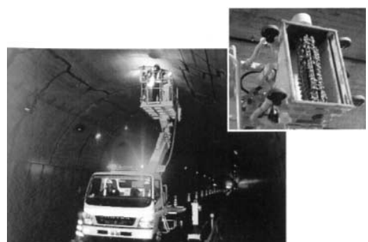
図一6 トンネル覆工打音点検システム
