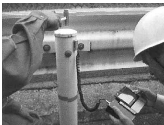
図—10 防護柵支柱の地中埋込深さ検査
