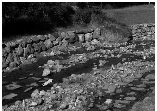
写真一九 護岸の一部として使用した転石
