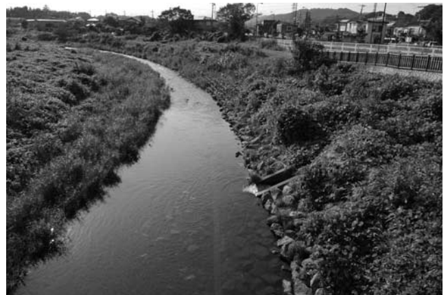
写真—3 平井川：根固工の位置が浅いため淵が失われている （出典：ポイントブック）
