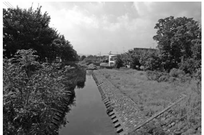
写真—1 境川：定期断面で狭い流路を固定している （出典：ポイントブック）
