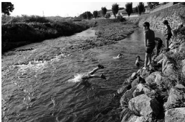
写真-4 平井川：外湾部の護岸を急傾斜とし、根固工を深い位置に設置している（出典：ポイントブック）
