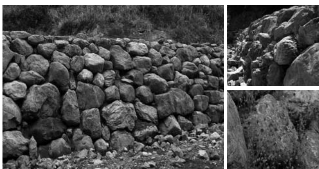
写真—10 深目地施工（左）と目地に詰めた地元の種子入り粘土（右） 胴コンが露出すると一枚ののっぺりとした法となり護岸の存在感が強調されるが、深目地にすると個々の素材が分離し法の存在感が和らぐ。深目地は空隙が多く植物が繁茂しやすい。目地から繁茂する植物は単調な法面のアクセントとなるだけでなく、植物の繁茂が旺盛になれば法面を隠す効果が期待できる。
