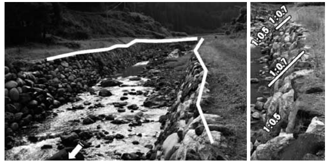
写真一八 山附川の護岸工法
