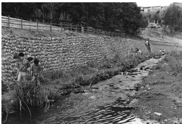
写真-6 早瀬を手本にした斜路（出典：ポイントブック）
