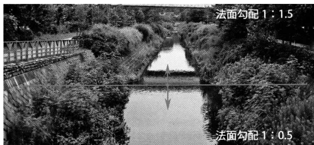
写真-5 上下流での法面勾配の違いにより、水際の植生状況が違って例（出典：ポイントブック）
