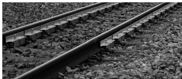
写真—4 レール吸音材の敷設状況
