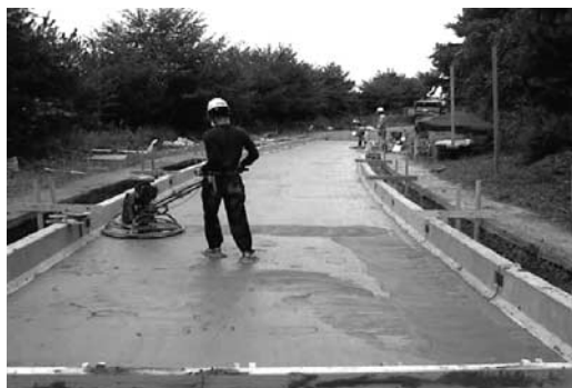
写真-2 下部スラブ設置
