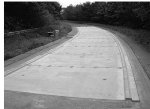
写真-3 上部スラブ設置
