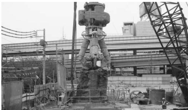
写真-1 ブロックに切断した障害物をつかみ出す (φ 2000)
