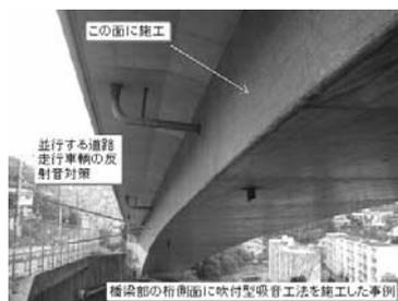
図二 コンクリート橋梁桁側面への施工例
