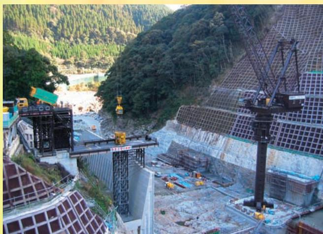
⇧タワークレーンによる下部ダムコンクリート打設状況
