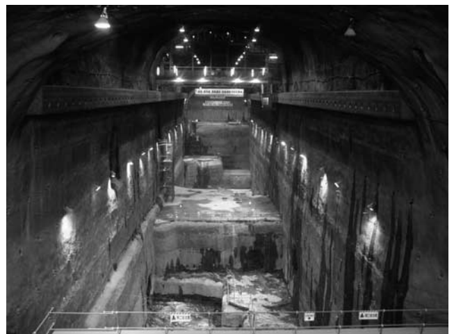
写真—1 掘削完了後の発電所本体の空洞状況
