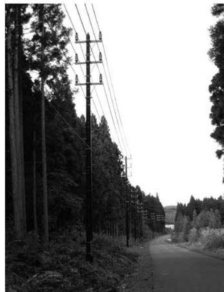
写真—2 コンクリート柱送電線
