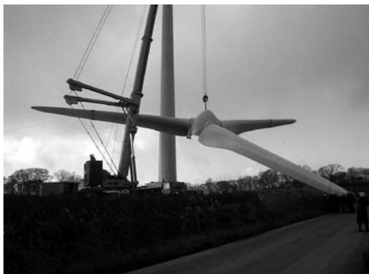
写真-6 ロータ吊り込み状況
