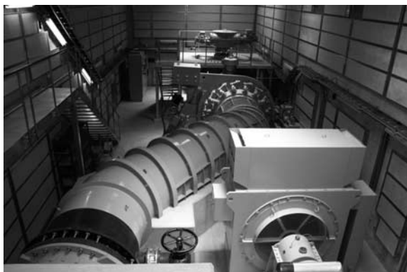
写真一2 発電機・水車 据付完了
